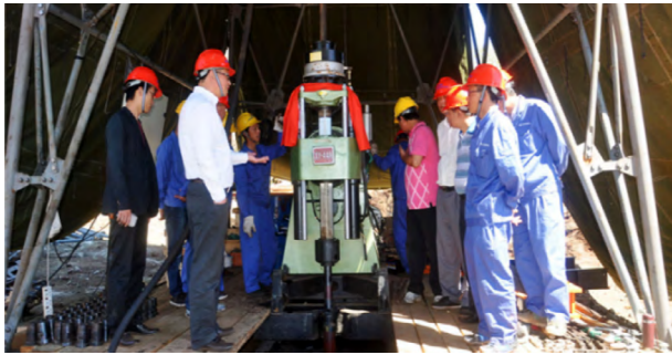
津巴布韦地质勘探钻井现场
