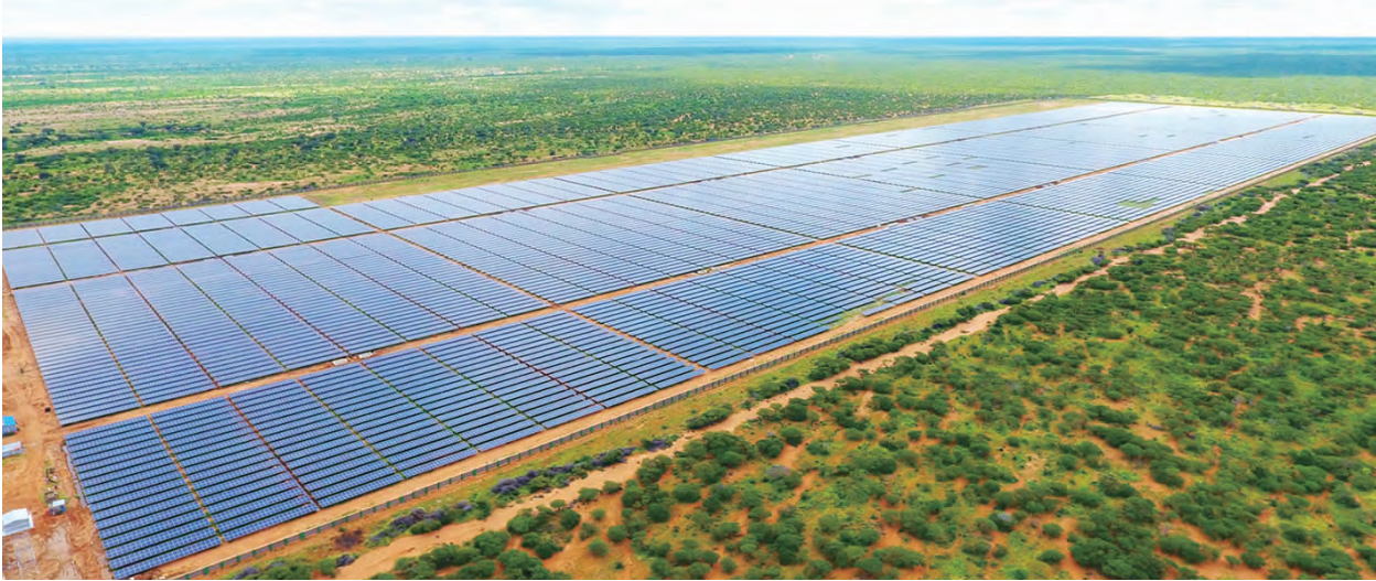
肯尼亚加里萨 50 兆瓦太阳能电站项目运行期 25 年内预计年发电量为 7646.7 万千瓦·时，每年可为当地减少约 6.419 万吨二氧化碳排放量，可节约标准煤约 2.447 万吨
