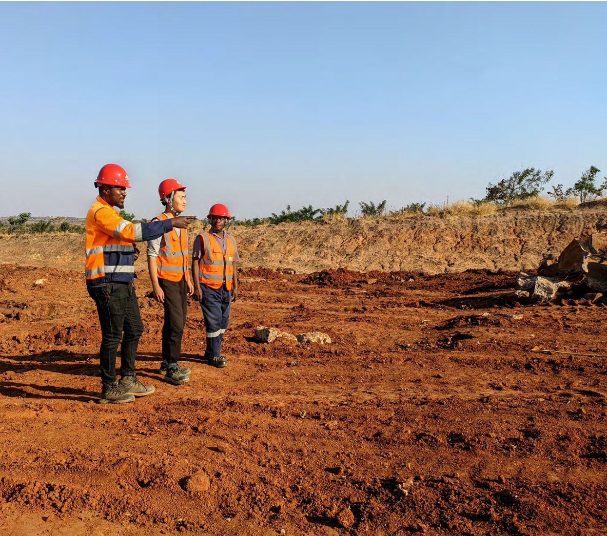
马拉维 M1 公路项目施工现场取土场回填，以便复耕
