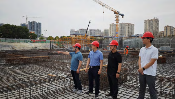
安全检查组前往庐山项目检查
