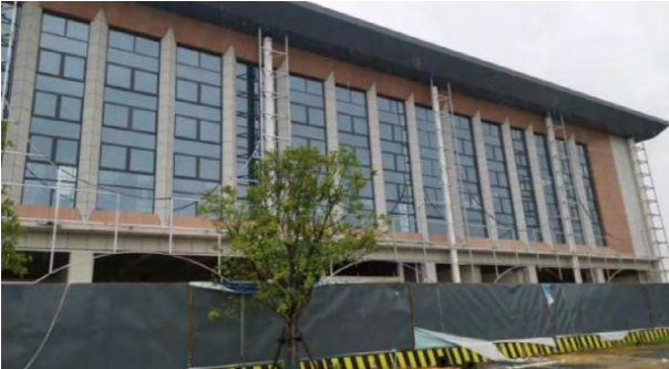
门窗施工现场
